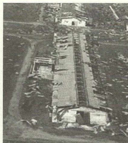
Große Schäden an Wirtschaftsgebäuden
