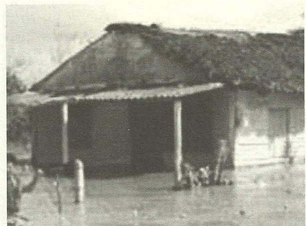
Überschwemmtes Wohnhaus in Matanzas
