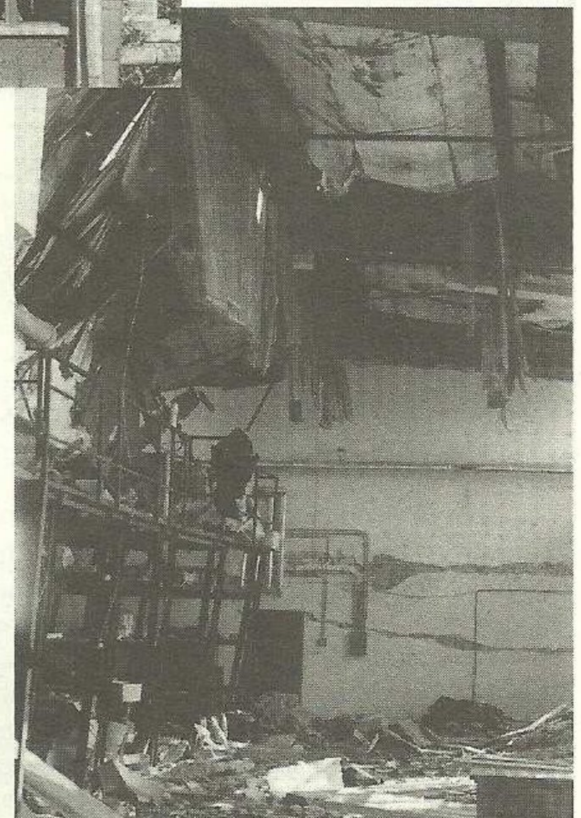
... sind restlos zerstört.
